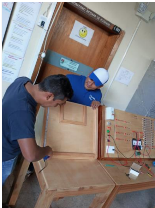
Figura III.8. Acoplamiento del módulo correspondiente al sistema principal de 13.8kV con conductor 4/0 ACSR AWG
