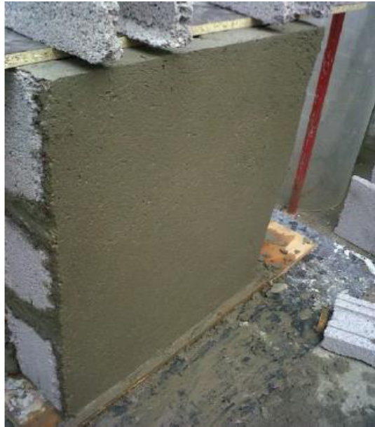
Figura 2.10. Enlucido de los prismas. Aplicado a los dos costados con un espesor de 0.5 cm
