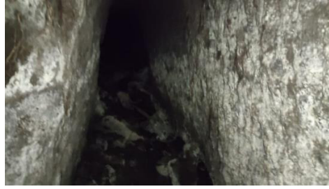
Figura 4 Segunda Galería de Captación
