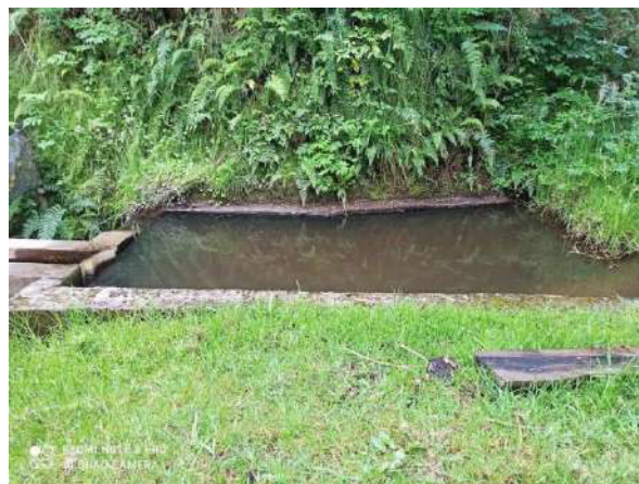
Figura 3.2: Desarenador
