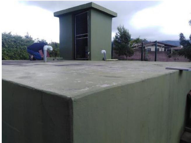
Figura 6 Tanque de distribución, vista exterior.
