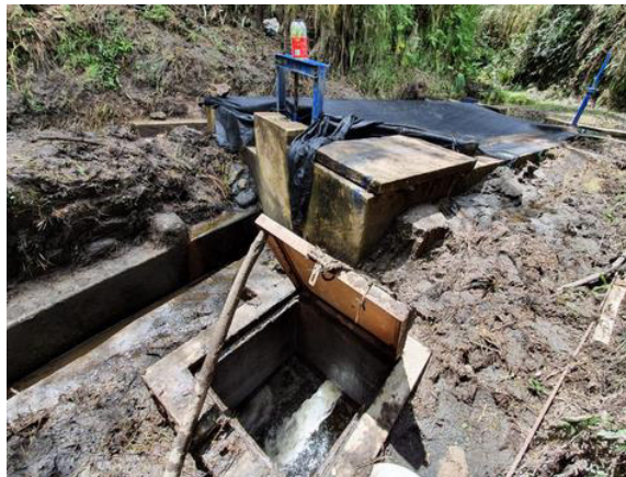
Figura 3 Captación, vista interna.
