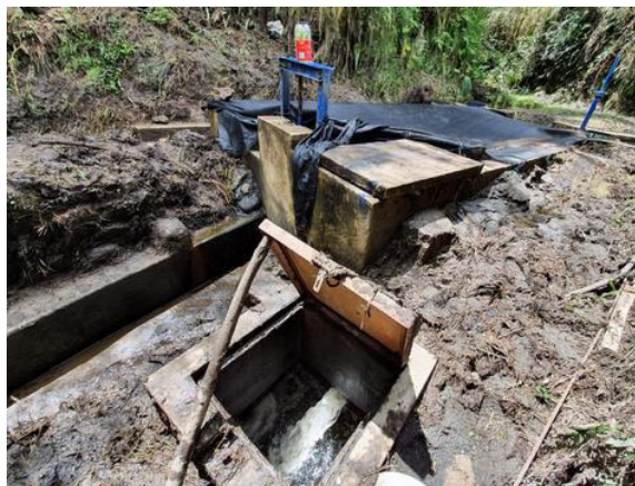
Figura 3 Captación, vista interna.
