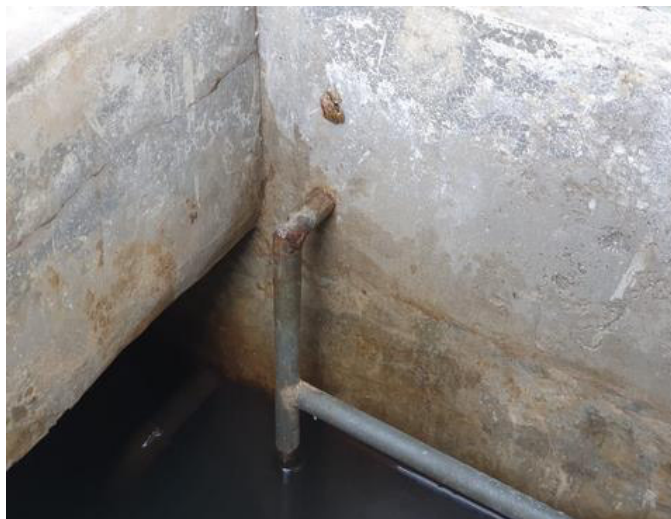
Figura 7 Tanque de distribución, vista interna.
