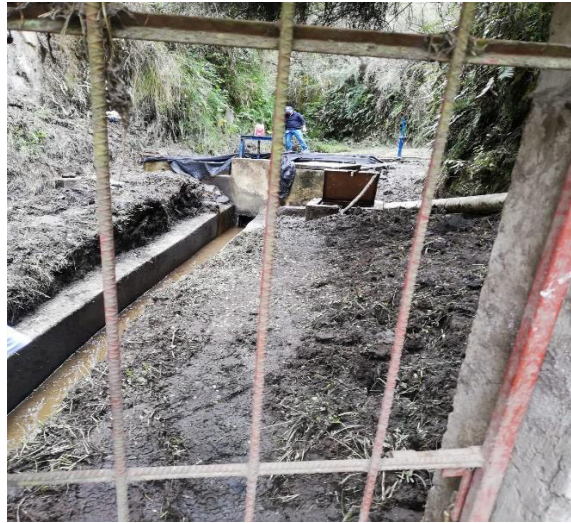
Figura 2 Captación, vista exterior.
