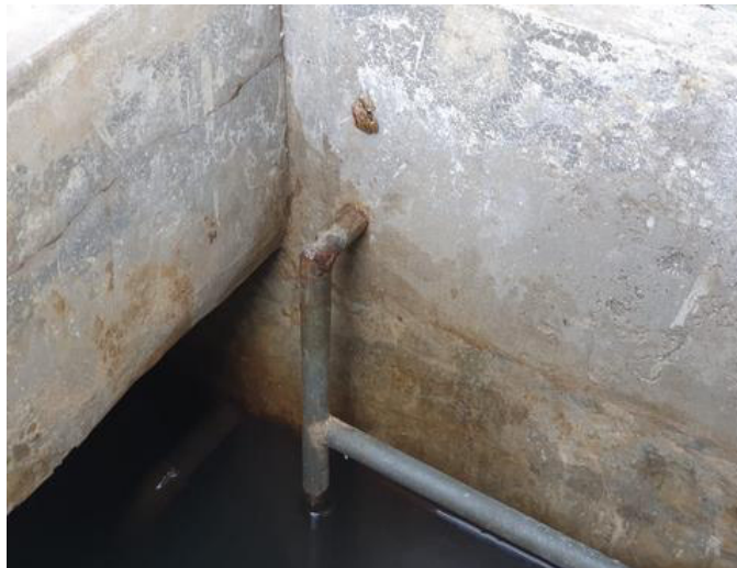
Figura 7 Tanque de distribución, vista interna.
