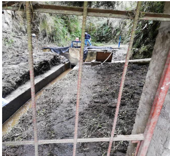
Figura 6 Captación, vista exterior.
