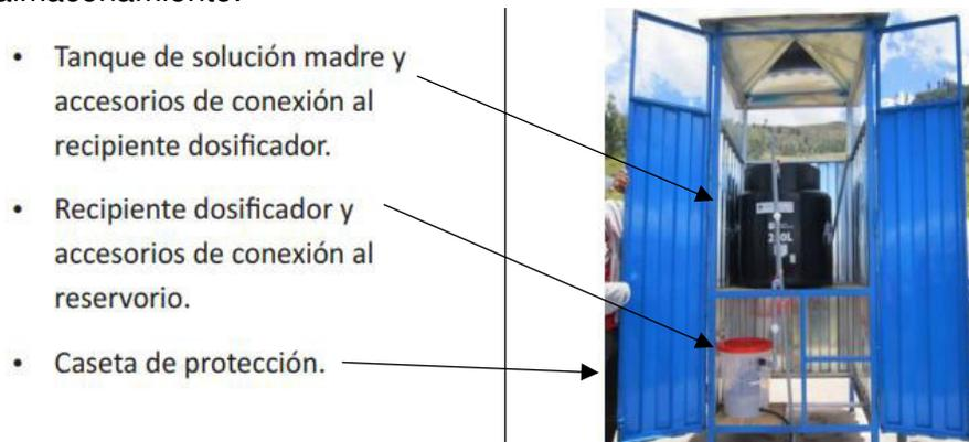
Figura 1. Partes del hipoclorador de goteo de carga constante (doble recipiente)
