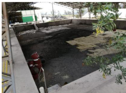
Figura 2.2 Zona de encapsulamiento que maneja Hazwat
