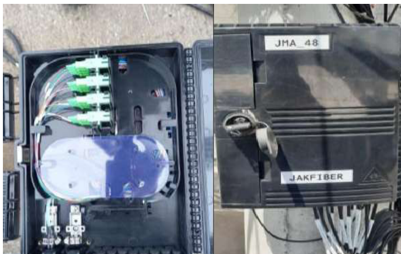
Figura 3.22 NAP con splitter 1:16
