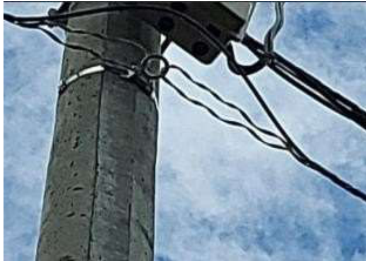
Figura 3.20 Sujeción del preformados
