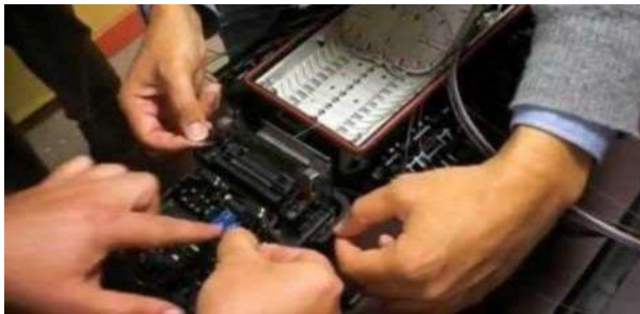
Figura 3.26 Empalme por fusión
