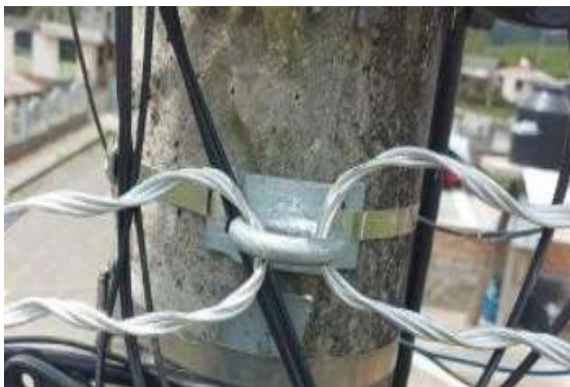
Figura 3.18 Herraje implementado en el poste
