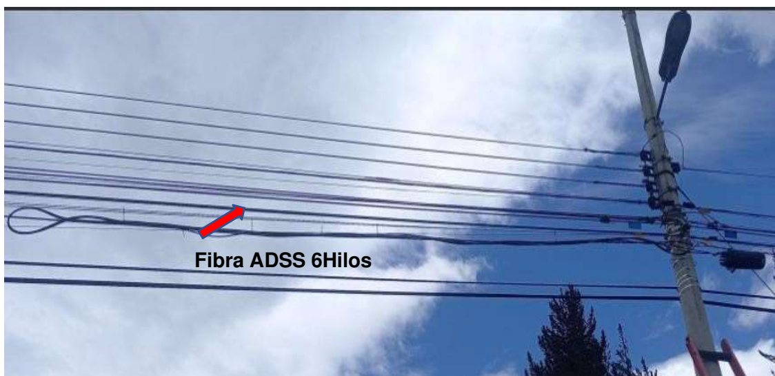
Figura 3.21 Tendido de cable fibra óptica ADSS
