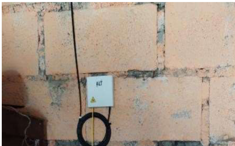
Figura 3.23 Fibra DROP guiada con grapas
