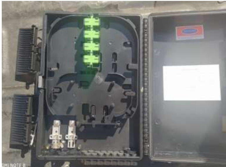
Figura 1.5 Caja terminal o NAP
