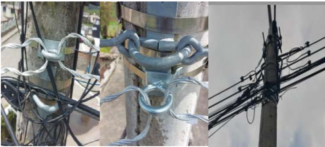
Figura 3.8 Dos herrajes tipo A y uno de paso
