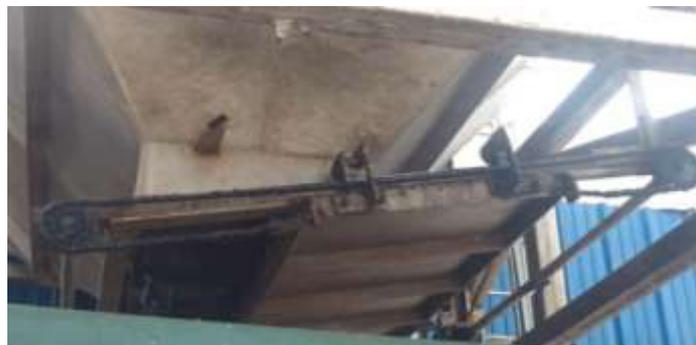
**Figura 1.7.** Compuertas guiadas por cadena.
