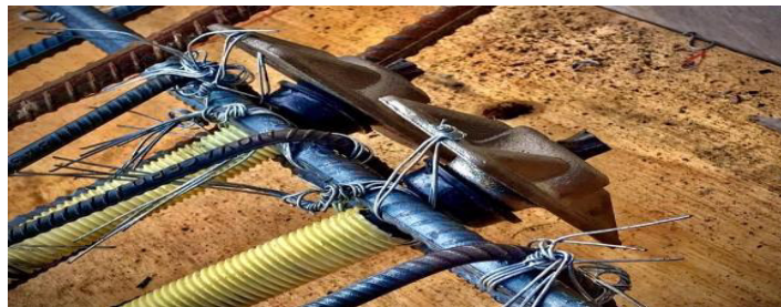
Figura 8. Anclajes pasivos
