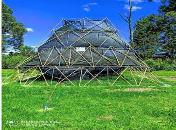
**Figura 9.** Modelo Captador de Niebla Piramidal instalado
