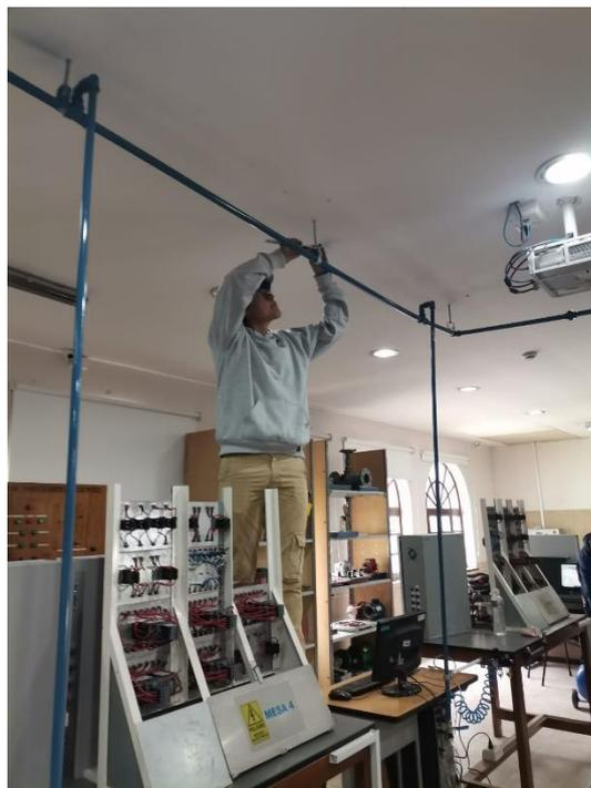
**Figura 3.13** Soportes regulables anclados al techo.
