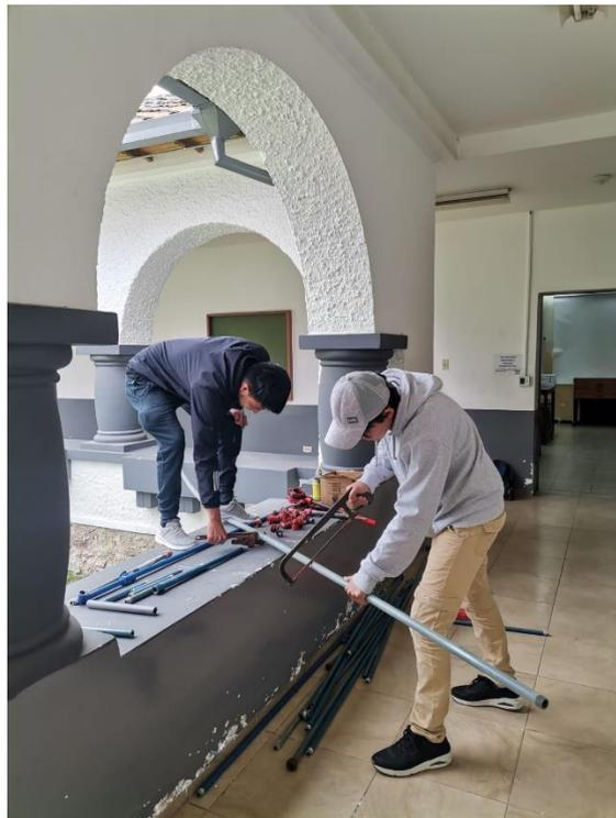
**Figura 3.11** Cortes de las tuberías
