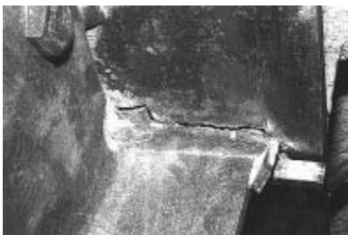
Figura 2.23 Fallas en la conexión viga – columna en sismo de Northridge Fuente: (FEMA 355F)
