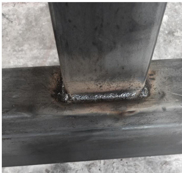
Figura 3.7 Soldadura de la conexión viga columna Foto: Nicole Guerrero
