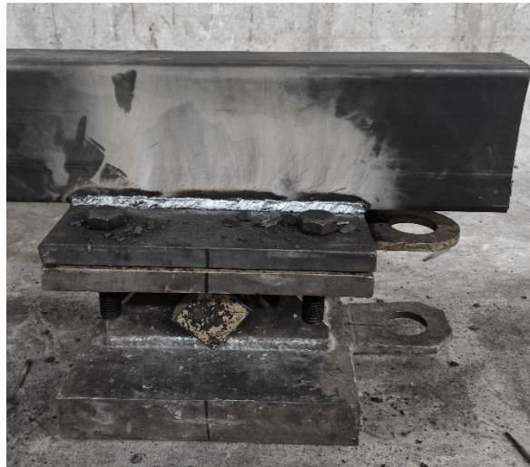
Figura 3.6 Soldadura de la columna a las placas Foto: Nicole Guerrero
