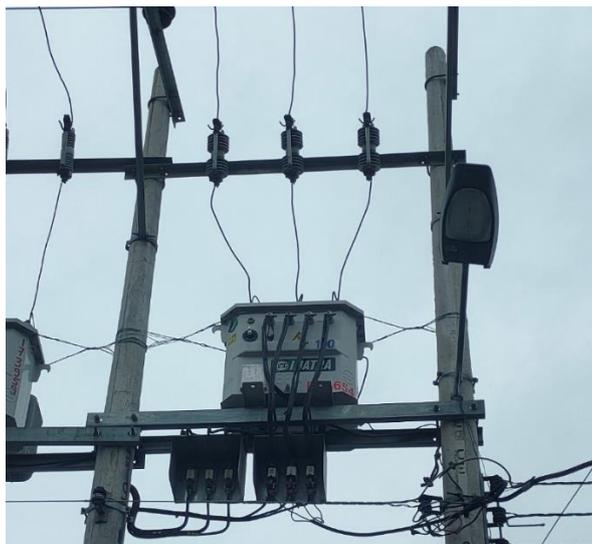
**Figura 2.14.** Transformador de distribución de la fábrica Klass Muebles
