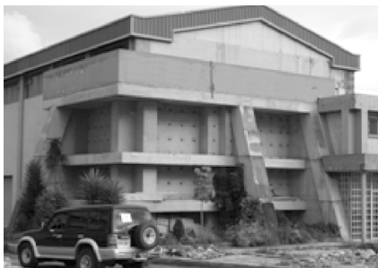
Arriba, Centro de Investigaciones y control ambiental, CICAM. Abajo, Centro de investigaciones sobre la vivienda.
