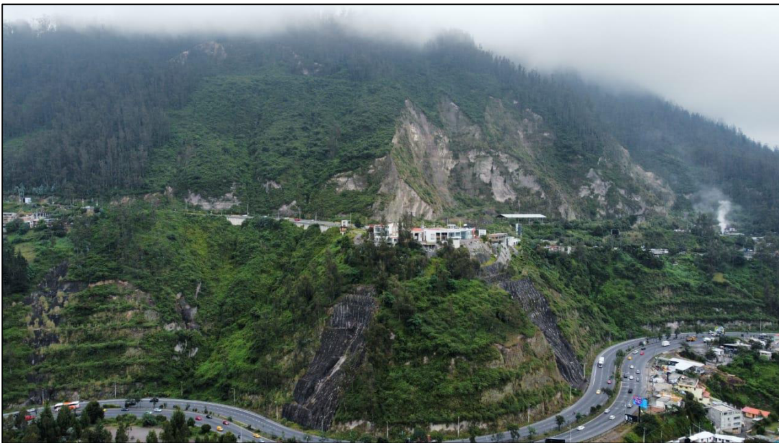
Figura 4.20 Deslizamientos con obras de estabilización en taludes de corte de la Av. Simón Bolívar (fotografía tomada con dron). Tomado de Zapata (2022).
