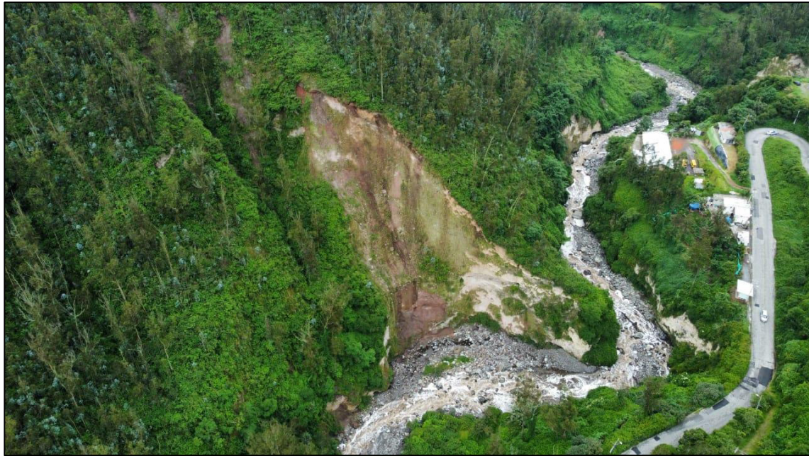
Figura 4.21 Deslizamiento producido por la erosión del río Machángara (fotografía tomada con dron). Tomado de Zapata (2022).
