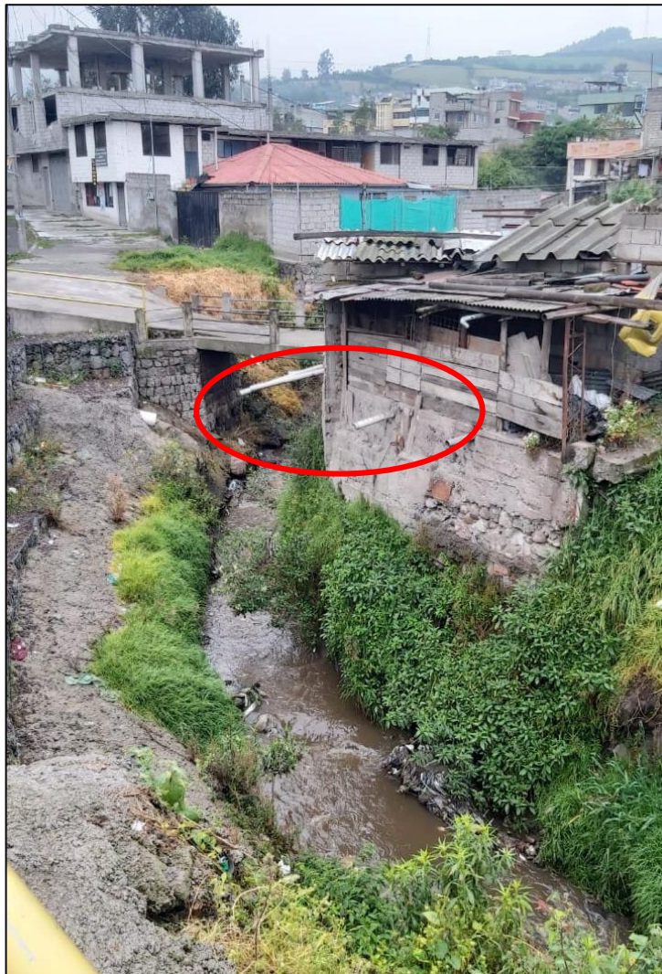
Figura 4.19 Quebrada Río Grande con influencia antrópica por la presencia de viviendas aledañas y descarga de aguas servidas (en círculo rojo).
