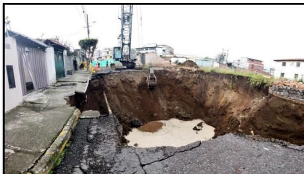
**Figura 4.4:** Fotografía sobre las afectaciones ocurridas a causa del hundimiento en el sector de Pomasqui del 22 de abril del 2011, proporcionada por EPMAPS (Tomado de diario El Comercio).
