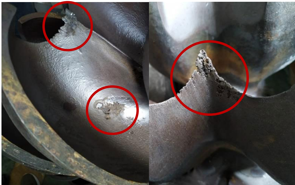
Figura 1.10 Desgaste hidro-abrasivo en el rodete Pelton. (Fuente: ELEPCO S.A [7])
