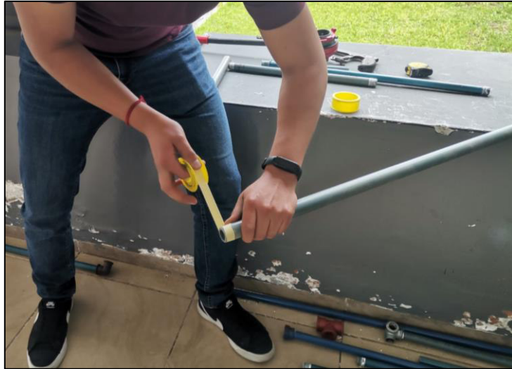
Figura 3.20 Colocación de teflón en roscas
