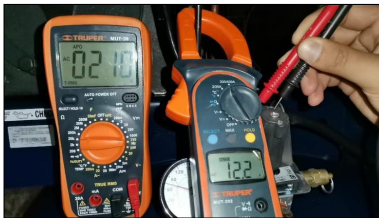
Figura 3.36 Voltaje medido en el compresor.
