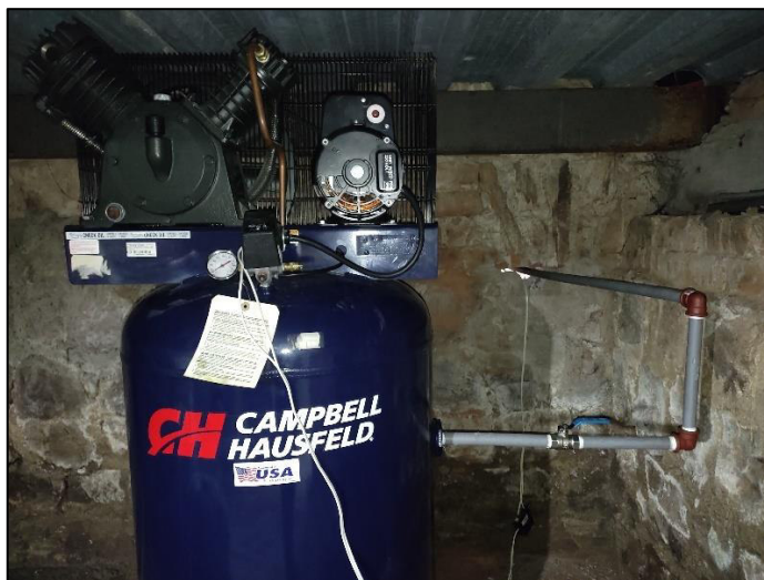
Figura 3.16 Construcción de línea de distribución desde compresor
