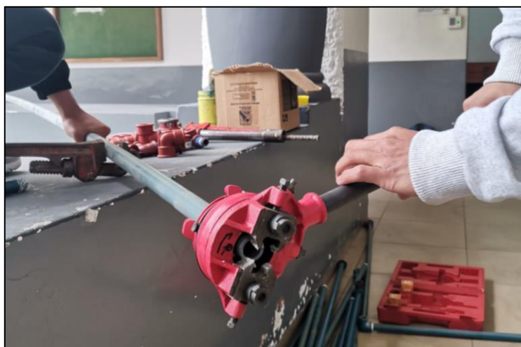
Figura 3.19 Roscado de tubería
