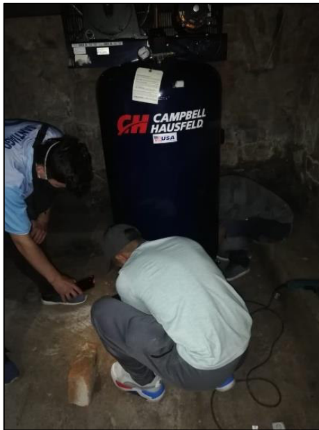
Figura 3.14 Proceso de anclaje del compresor
