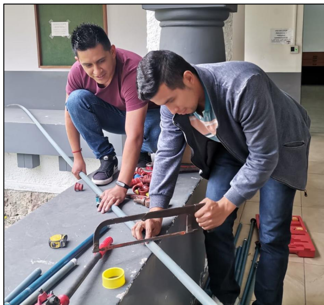
Figura 3.18 Corte de tubería de longitud necesaria
