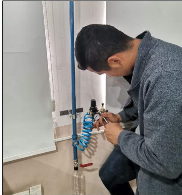
Figura 3.24 Instalación de FRL y purgas de condensado
