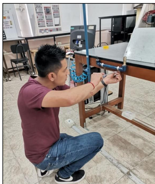
Figura 3.25 Instalación de accesorio para conexión de transductores de presión
