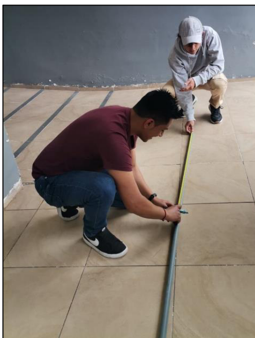
Figura 3.17 Medición de longitudes necesarias de tubería
