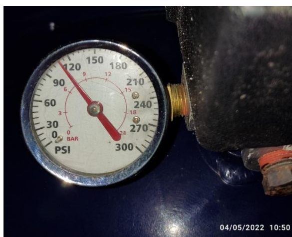
Figura 3.31 Lectura inicial una vez presurizado el sistema
