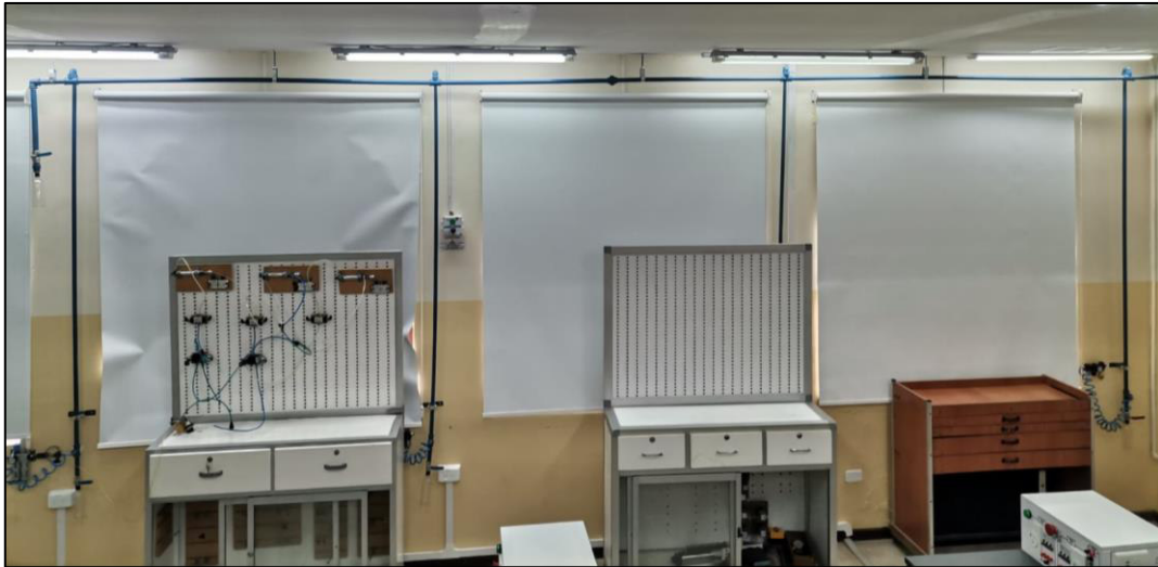
Figura 3.22 Tendido de líneas de distribución principal
