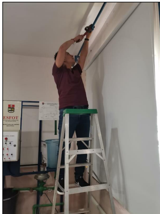
Figura 3.21 Sujeción de tuberías al tumbado
