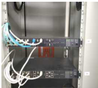
(d) Switches Ruggedcom
