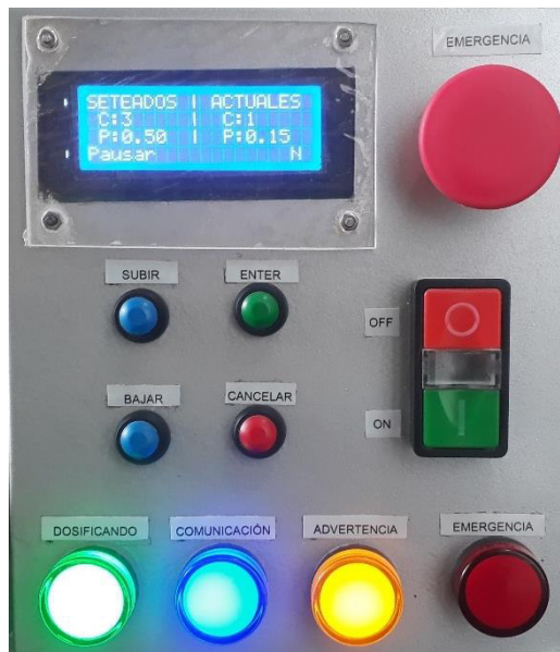
Figura 3.9. Alarma preventiva de nivel bajo activada en el prototipo
