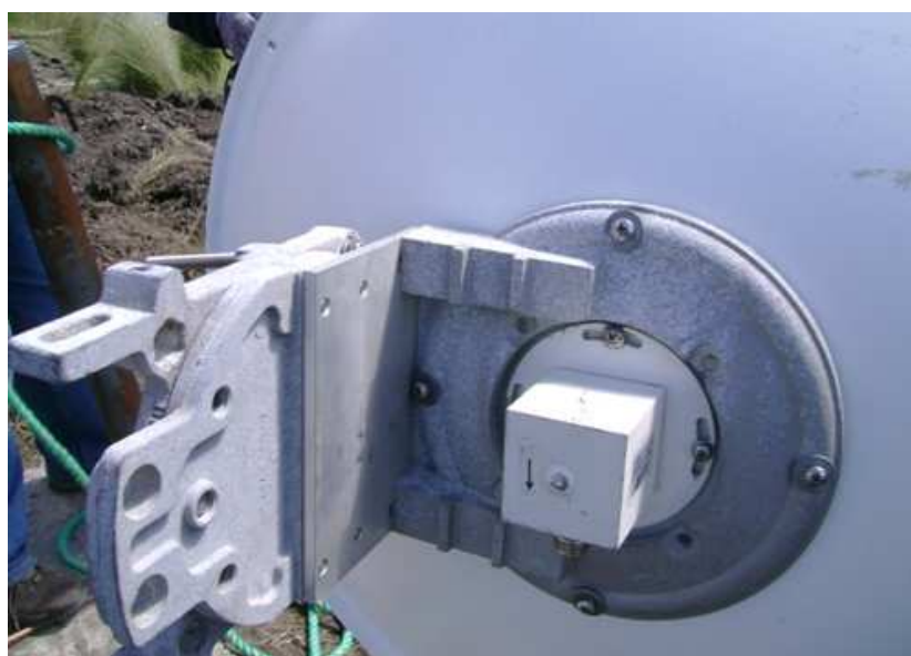
Figura 3.12 Montaje del mecanismo de anclaje
