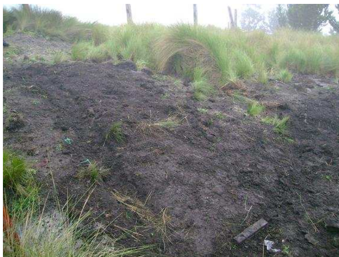
Figura 3.4 Cobertura de zanja concluida
