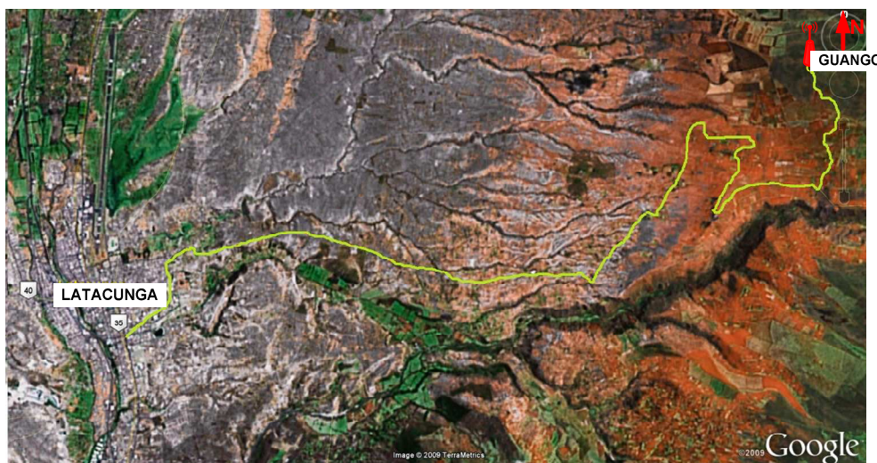
Figura 2.7 Carretera de acceso al nodo Guango (Zona oriental de Latacunga)
