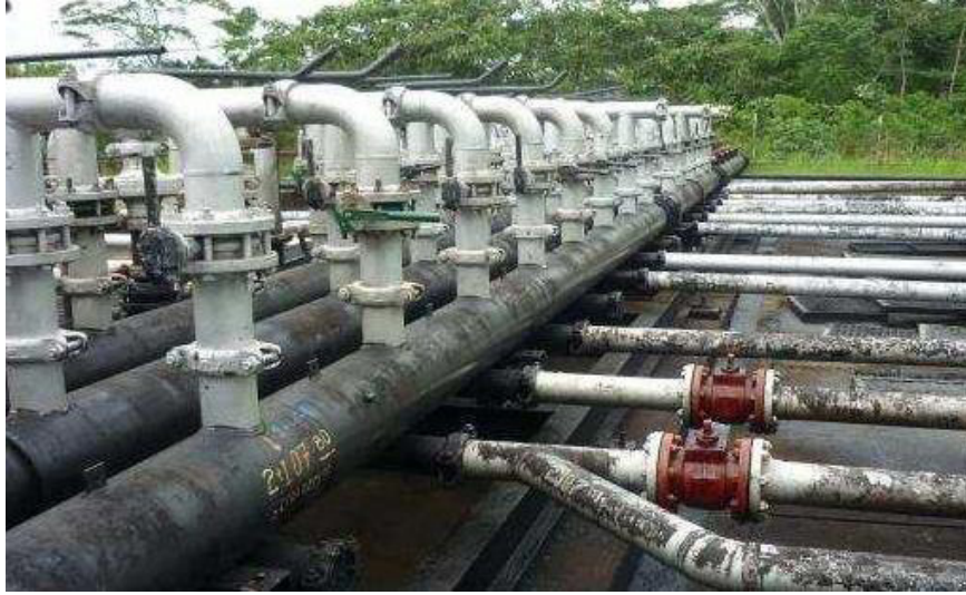
Figura 2.3. Manifold estación Sacha Norte 1 (Petroecuador, 2022)
