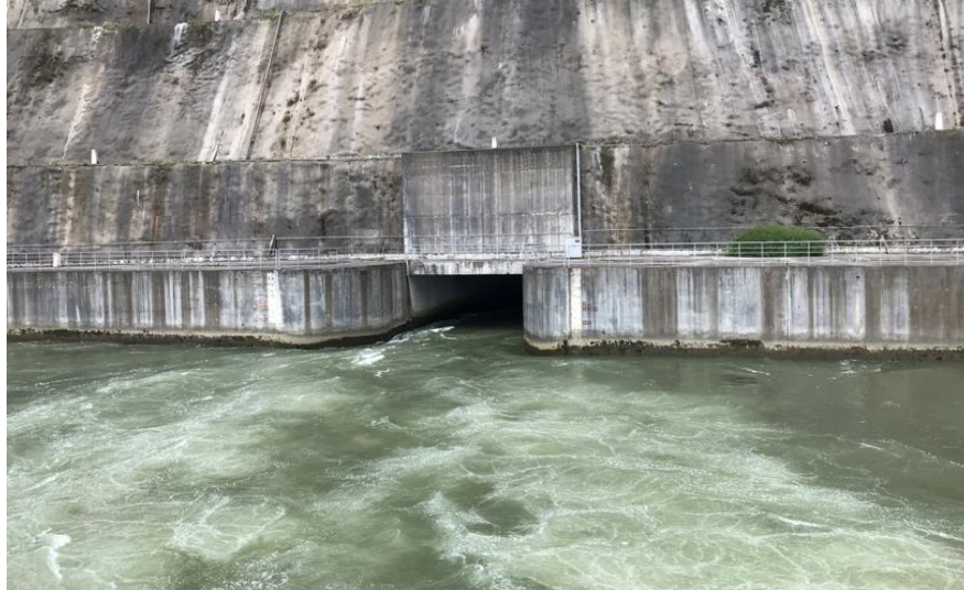
Figura 9. Entrada al túnel central Coca Codo Sinclair.
