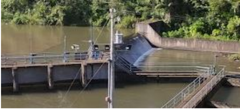
Figura 4. Azud de la central hidroeléctrica Palmira Nanegal
