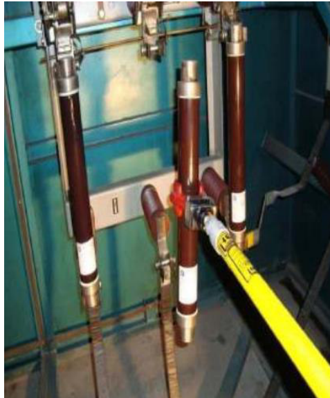
Figura 3.24. Reemplazo de fusibles en celdas de MV.
