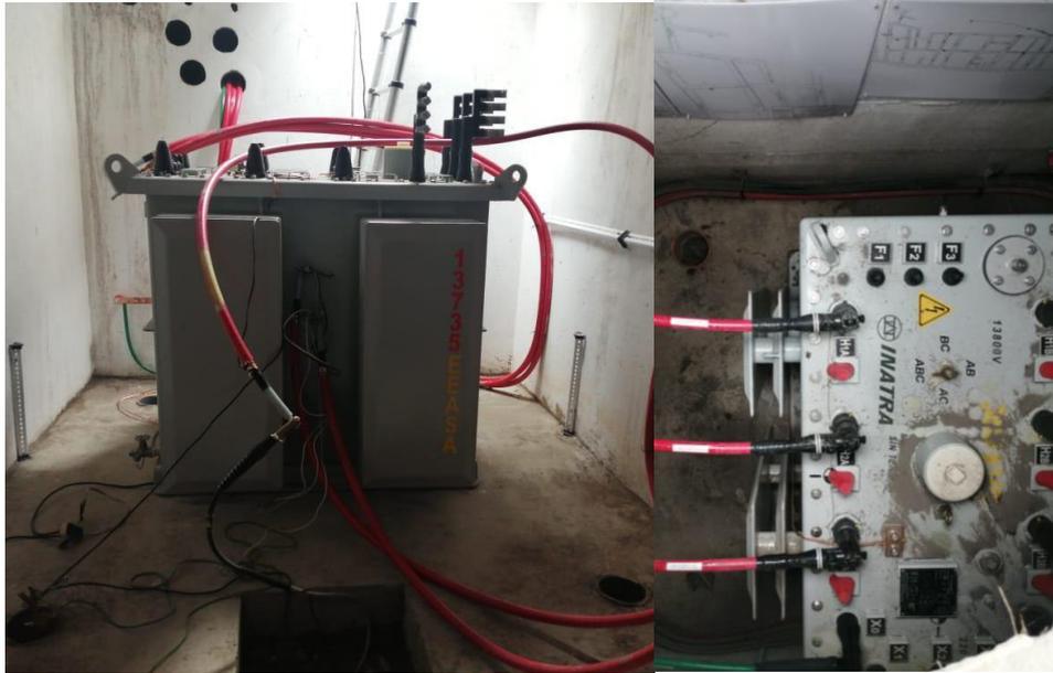
**Figura 2.9.** Transformador sumergible instalado en la red eléctrica subterránea del centro de la ciudad de Ambato (elaboración propia).
