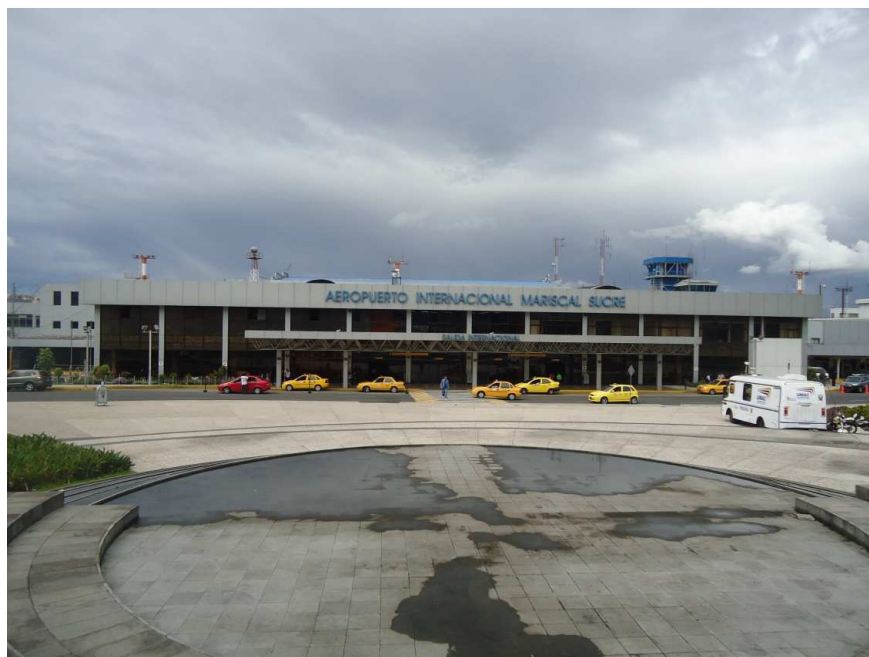
Fotografía 2.5 Visita Terminal Aérea “Mariscal Sucre” (Quito – provincia de Pichincha).
