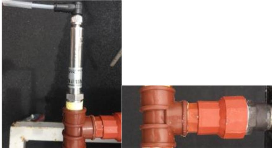
**Figura 18.** Conexión de los sensores a entrada y salida del colector (Fuente: Propia).
