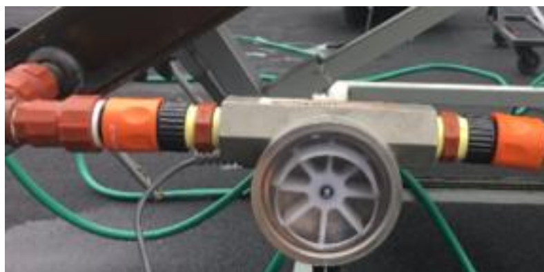
Figura 21. Adaptación del medidor de caudal a la entrada del colector (Fuente: Propia).
