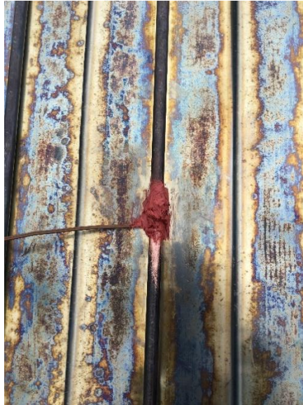
Figura 18. Instalación de la termocupla tipo J en el absorbedor (Fuente: Propia).
