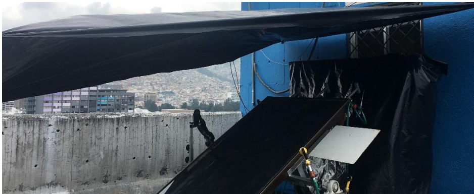
Figura 31. Almacenamiento del colector solar luego de realizar el ensayo de penetración de lluvia (Fuente: Propia).
