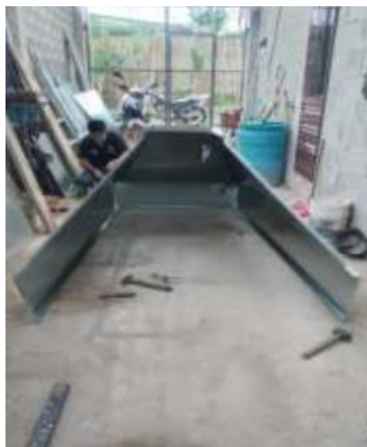
Figura AVII.9. Construcción de la sección piramidal
