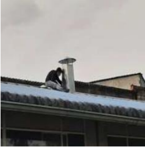
Figura AVII.12. Fijación del ducto de salida
