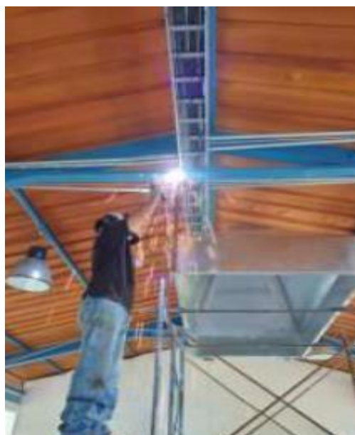
Figura AVII.10. Empotramiento de la campana al techo
