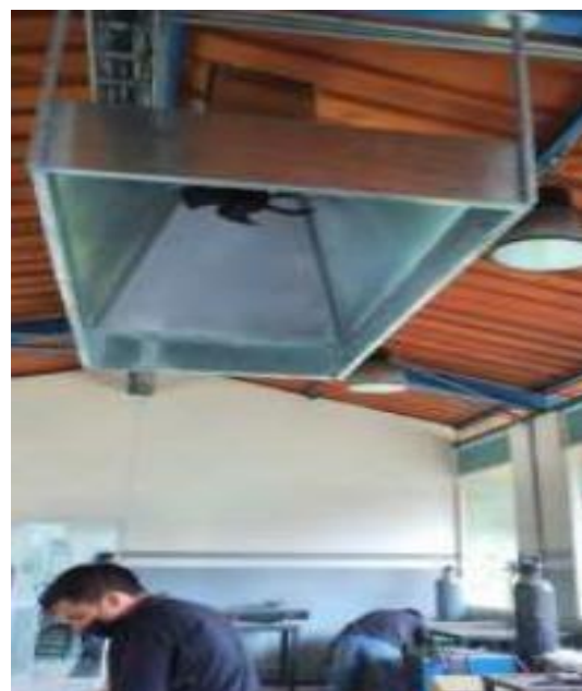
Figura AVII.11. Fijación del ventilador
