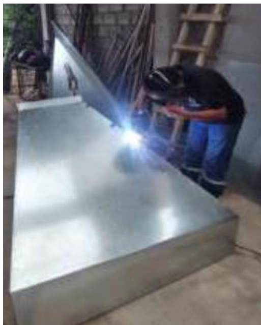
Figura AVII.8. Construcción de la campana
