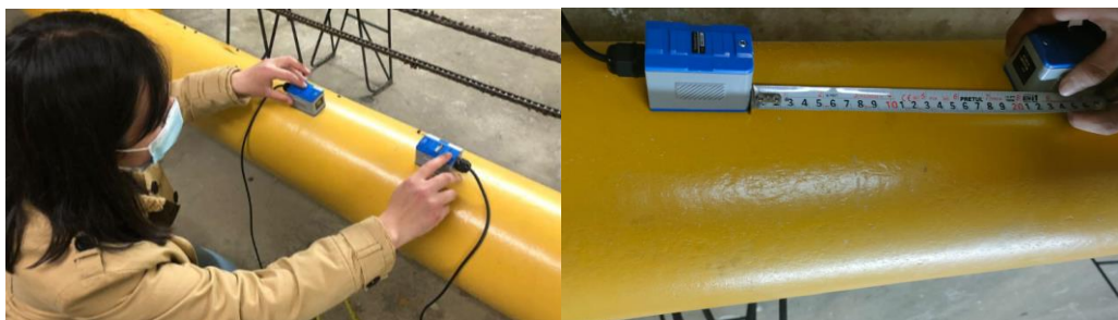
Figura 3.6. Ubicación de sensores en la tubería
