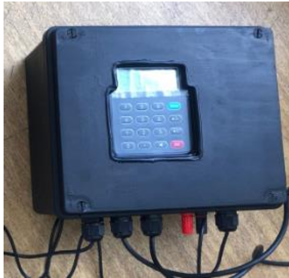
Figura 2.15. Implementación de la estructura
