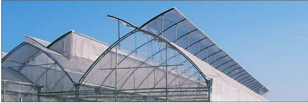
Figura 1.10 Sistema de ventilación natural para invernadero. [32]
