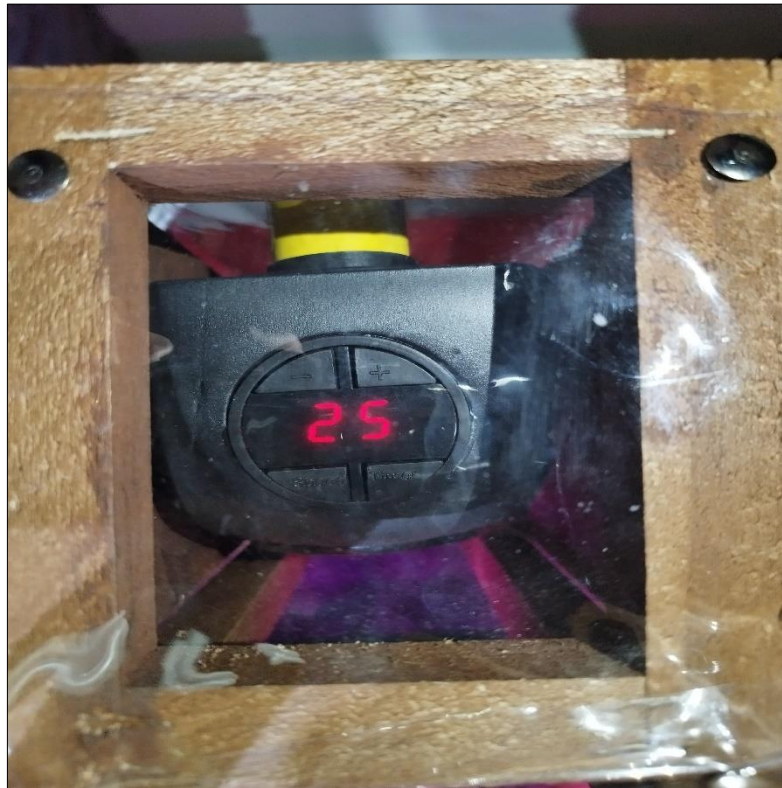
Figura 3.16 Sistema de calefacción encendido proporcionado una temperatura de 25 °C.
