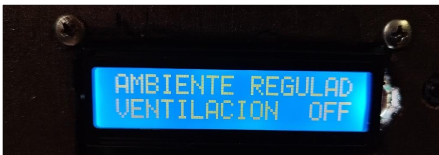
Figura 3.28 Mensaje de ambiente regulado después de la acción del sistema de ventilación – Caso III
