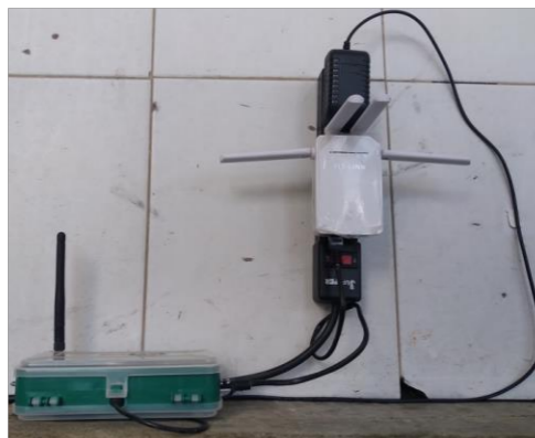
Figura 3.1.6. Instalación del nodo recolector. Fuente: Autor
