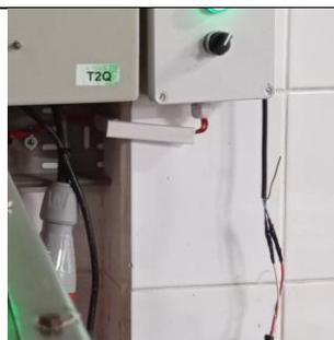
**Figura 2.12.** Conductores empalmados y expuestos al personal operativo. “Área producto y empaque de yogurt”.
