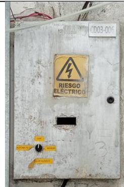
**Figura 2.9.** Tableros externos e internos en mal estado “Área recepción antigua”.
