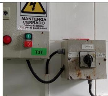
**Figura 2.13.** Seleccionador en mal estado “Área tratamiento térmico”.
