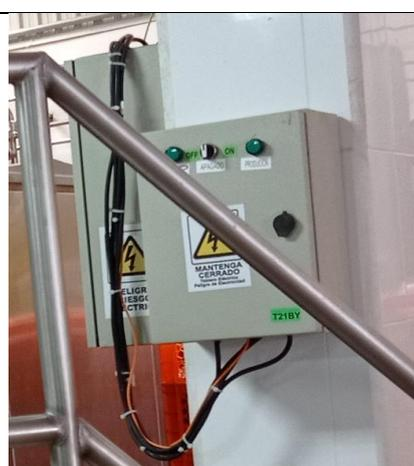
**Figura 2.3.** Conductores en el aire libre "Área preparación bolo yogurt"
