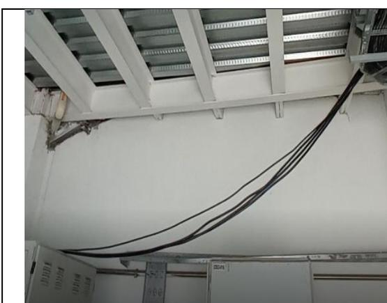
**Figura 2.2.** Conductores colgados no se encuentran dentro de bandejas.
