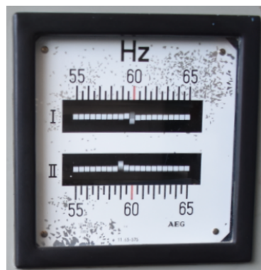
Figura 49. Frecuencia medida en el lado A y B por el sincronoscopio manual
