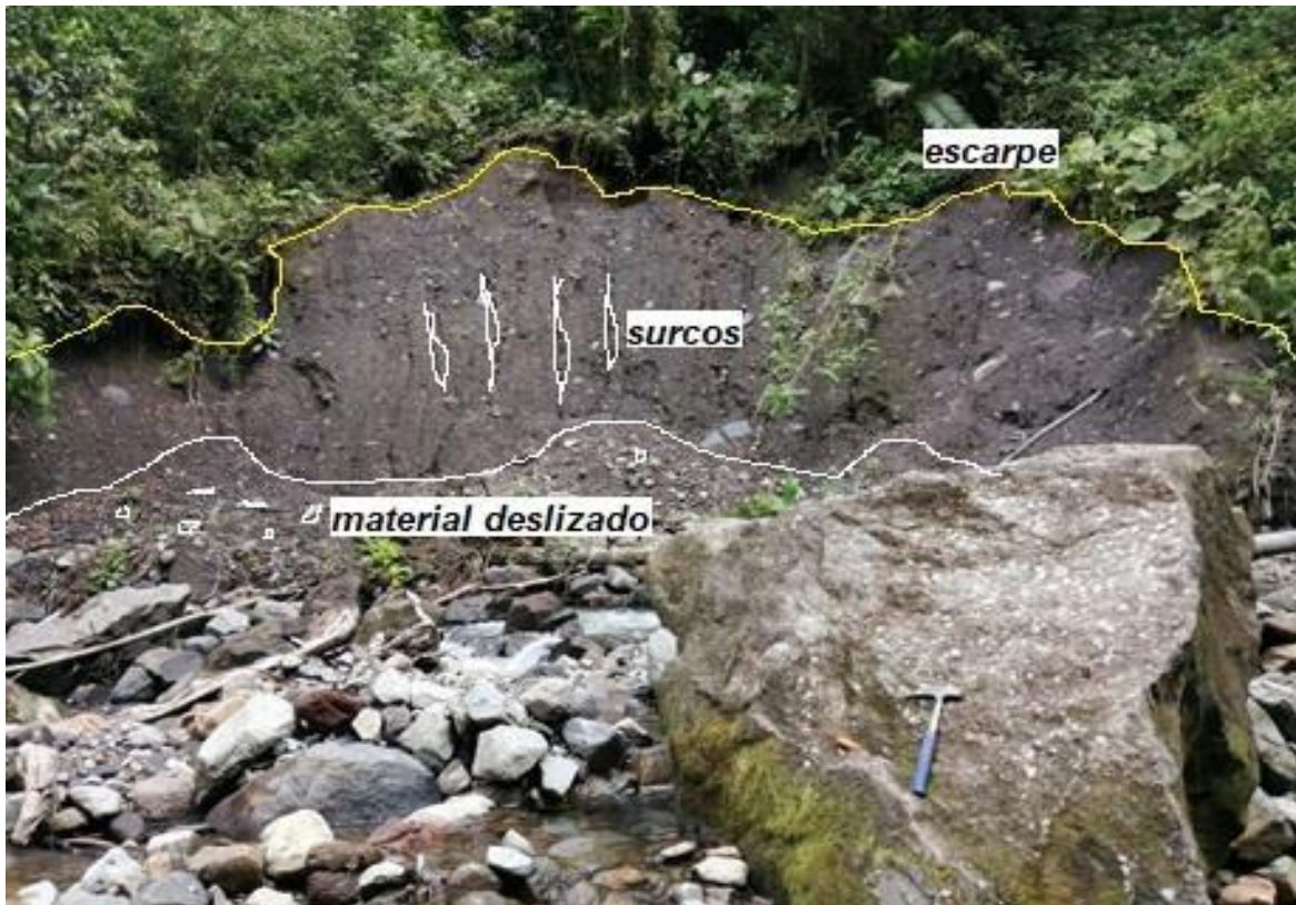
Figura 4. PF2 Movimiento en masa al margen derecho del río Piedra Fina 2 a 1357m.s.n.m coordenadas 209356 E 9985905 N
