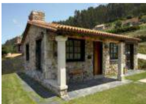
Figura 4. Mampostería no reforzada
