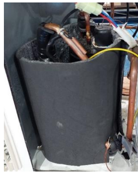
Figura XI. II Compresor con aislamiento térmico (Fuente: Propia)
