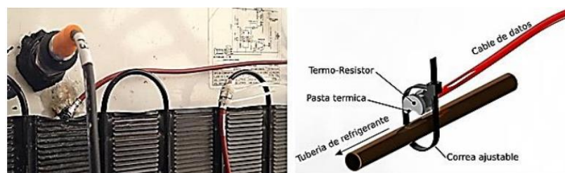
Figura 1. 9 Instalación y montaje de termoresistores externos
