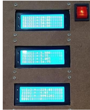
Figura XI. VII Sistema de control de temperaturas (Fuente: Propia)
