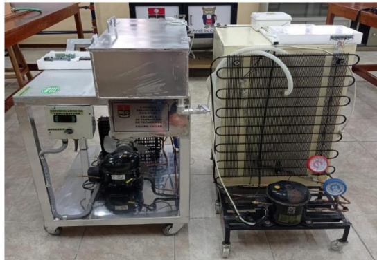
Figura XIV. I Equipo Chiller (R-134a) y Enfriadora de leche (R-413A)
