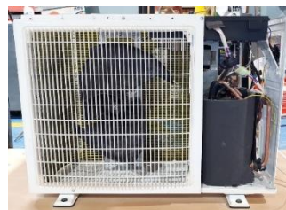
Figura XI. III Condensador del Split (Fuente: Propia)
