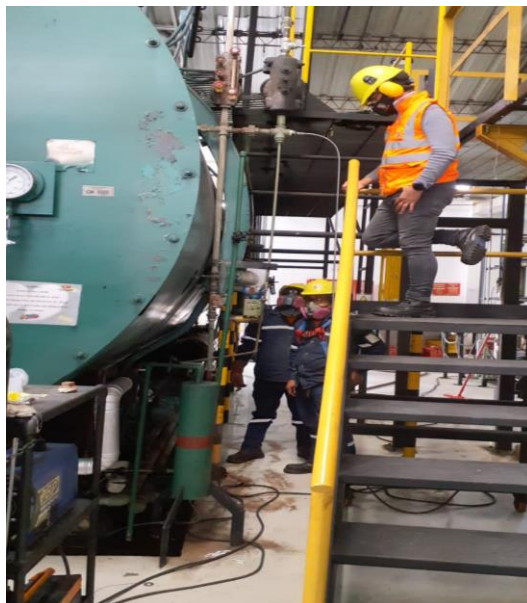
Figura 2.46. Instalación de un transmisor de presión en el caldero 4. (Fuente: Autor)
