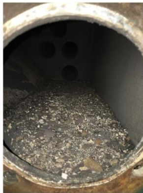
Figura 2.35. Ceniza de la parte trasera de la cámara de combustión, caldera 4. (Fuente: Autor)
