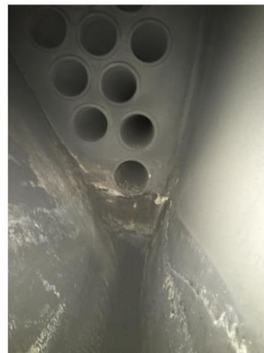
Figura 2.35. Ceniza de la parte trasera de la cámara de combustión, caldera 4. (Fuente: Autor)
