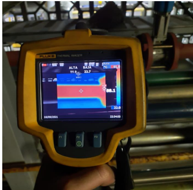
Figura 2.9. Ejemplo de medición de temperatura superficial de una tubería sin aislamiento. (Fuente: Autor)
