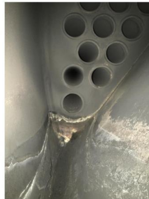
Figura 2.35. Ceniza de la parte trasera de la cámara de combustión, caldera 4. (Fuente: Autor)
