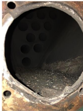
Figura 2.35. Ceniza de la parte trasera de la cámara de combustión, caldera 4. (Fuente: Autor)
