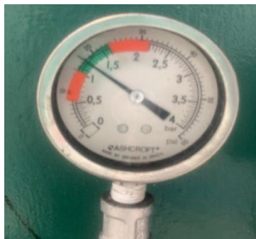
Figura 2.23. Presión del aire de atomización en el caldero 4. (Fuente: Autor)
