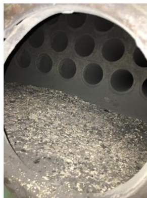
Figura 2.36. Ceniza de la parte trasera de la cámara de combustión, caldera 4. (Fuente: Autor)
