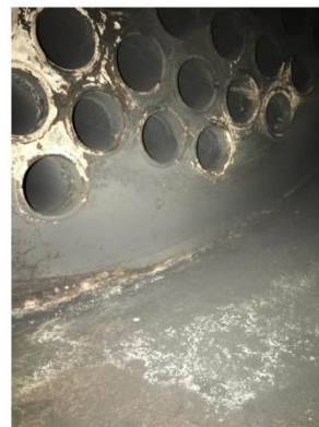
Figura 2.36. Ceniza de la parte trasera de la cámara de combustión, caldera 4. (Fuente: Autor)
