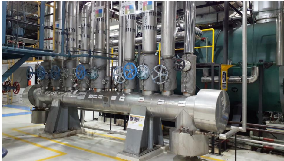
Figura 1.20. Distribuidor de vapor. (Fuente: Autor)
