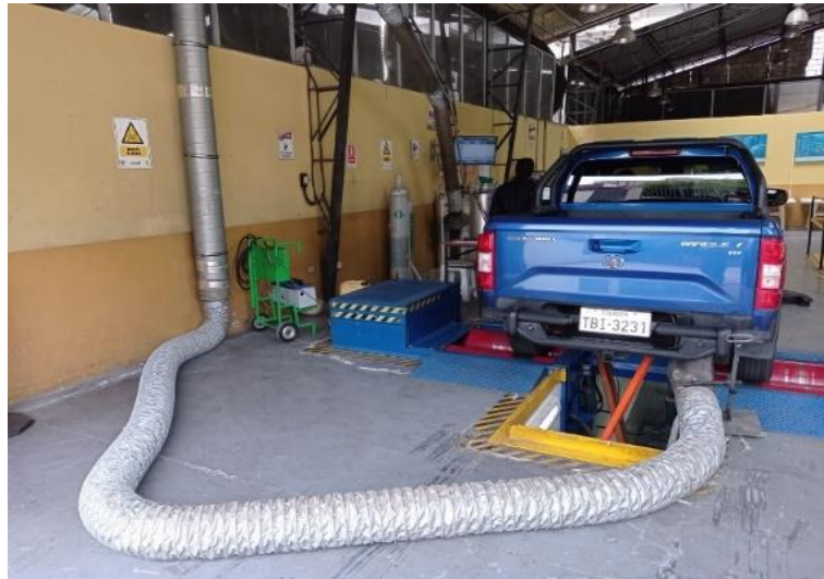
Figura 2. 15. Instalación de extractor de gases. (Fuente: Autores, 2022)
