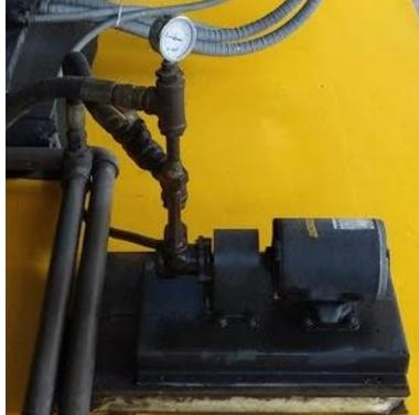
Figura 2.3 Bomba de suministro de diesel al quemador de la caldera.
