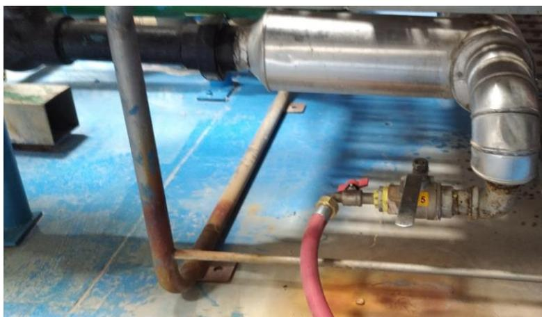
Figura 2.28 Conexión para medición de condensado
