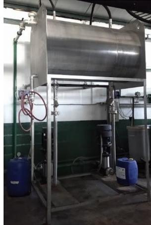
Figura 2.6 Tanque de alimentación.
