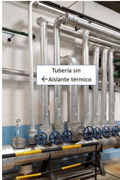
Figura 2.11 Tubería de vapor sin aislante de la MCS180
