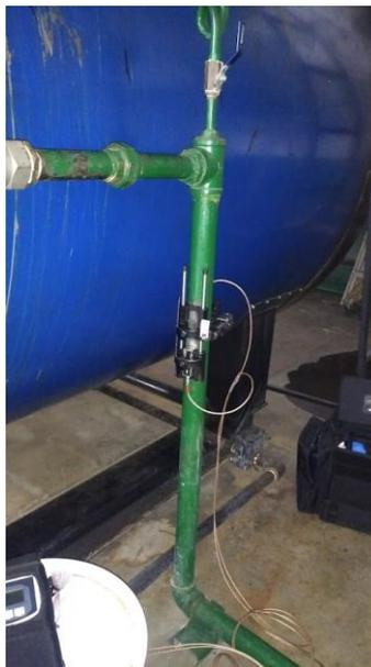
Figura 2.24 Instalación del caudalímetro ultrasónico
