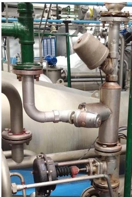
Figura 2.45 Fuga de vapor en la válvula de entrada de vapor, máquina TRD4
