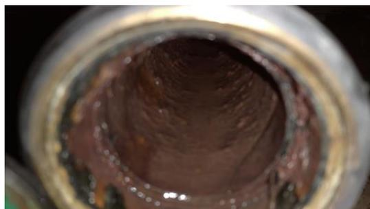
Figura 3.1 Interior de la tubería de ingreso de agua a la caldera
