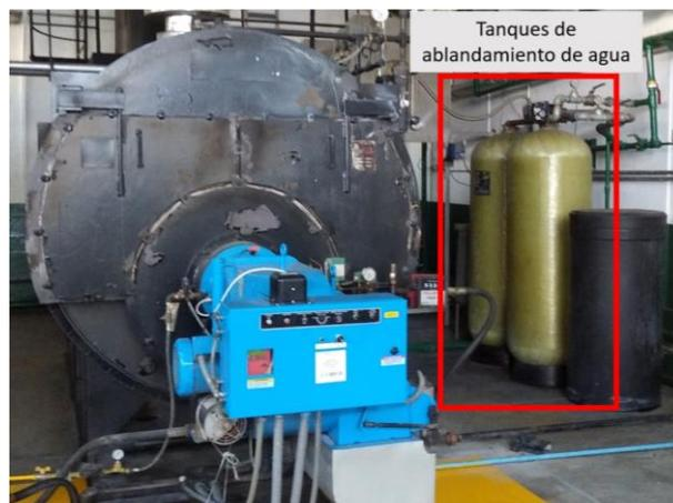
Figura 2.7 Tanques de ablandamiento de agua
