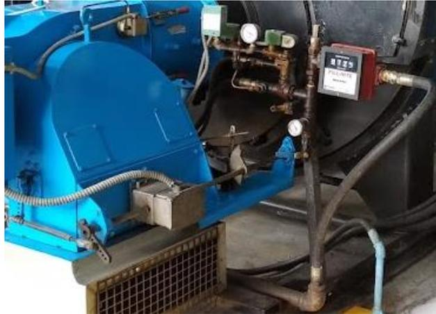
Figura 2.4. Sistema modulador aire/combustible.
