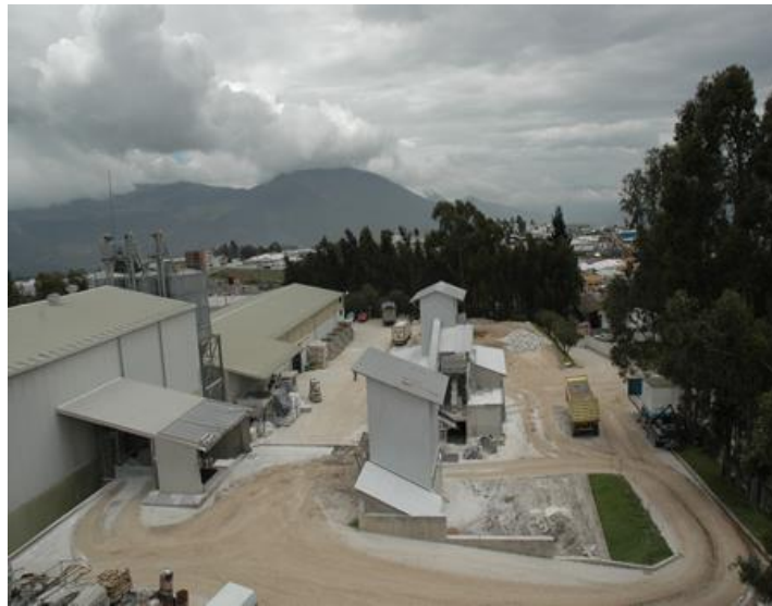
Figura 3.1 Fotografía de las áreas operativas planta Industrial de carbonato de calcio.
