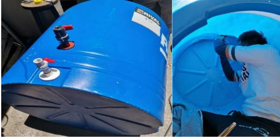
Figura 2.9 Conexiones laterales del biol y limpieza. Fuente: Propia.
