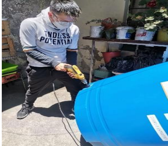
Figura 2.7 Perforación lateral del tanque. Fuente: Propia.
