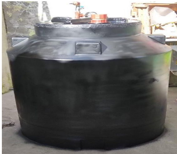
Figura 2.15 Soldadura y pintura del tanque. Fuente: Propia.
