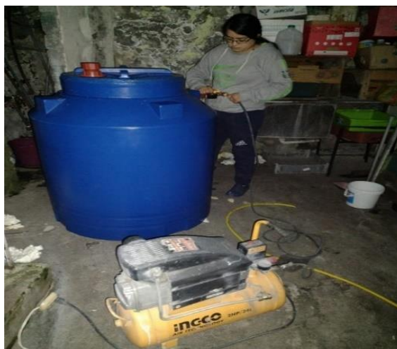
Figura 2.16 Conexión de compresor a biodigestor. Fuente: Propia.
