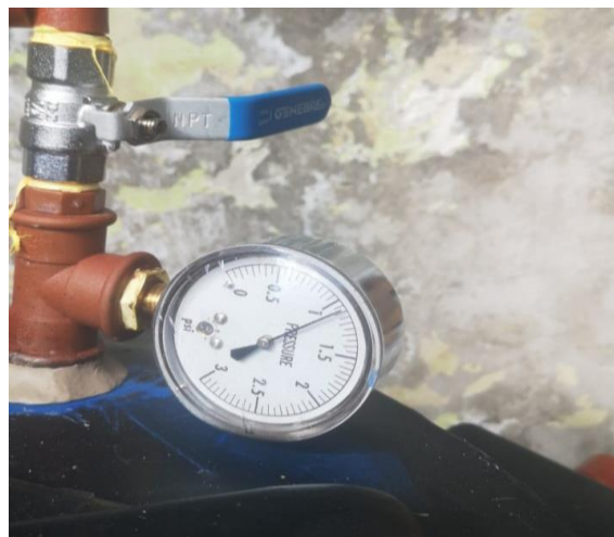
Figura 3.2 Incremento de presión en manómetro. Fuente: Propia.
