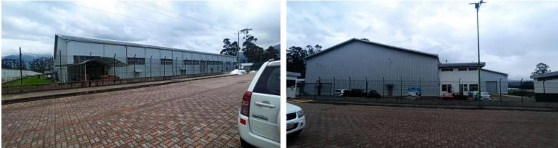
Figura 1.8 Fotografía de la Nave Industrial Flexyplast (Fuente: Propia)
