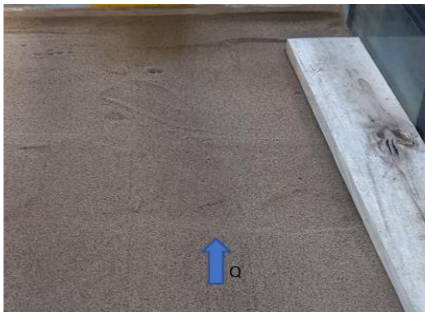
Figura 3.7. Capa de arena con espesor de 11 cm
