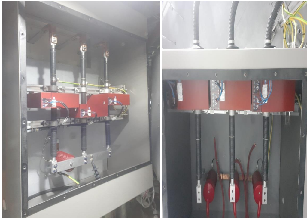
Figuras 1.10 a) TCs en el lado del Neutro. b) TCs en los terminales de la Máquina
