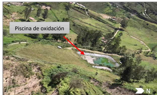
Fotografía 3.4 Piscina de oxidación (mayo, 2021). Ubicada en la mitad del talud en las coordenadas UTM (730199, 9747052), se utiliza para la acumulación de aguas residuales de la zona.
