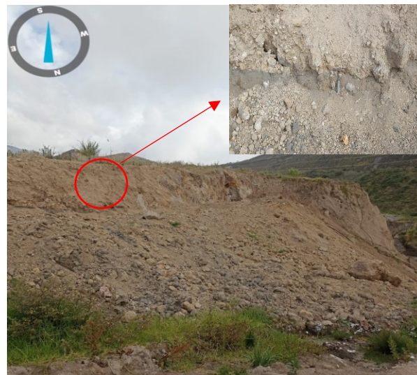
Fotografía 4.10 Depósitos coluviales con porciones de material fino como la arcilla en el pie del macrodeslizamiento La Armenia. UTM (728845 / 9747100)
