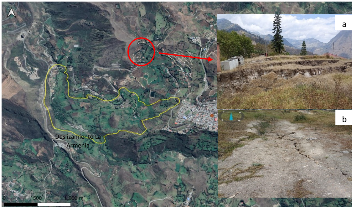
Fotografía 4.8 Zonas inestables a) Levantamiento del terreno en forma escalonada b) Grietas a lo largo del terreno. UTM (730130 / 9747899)
