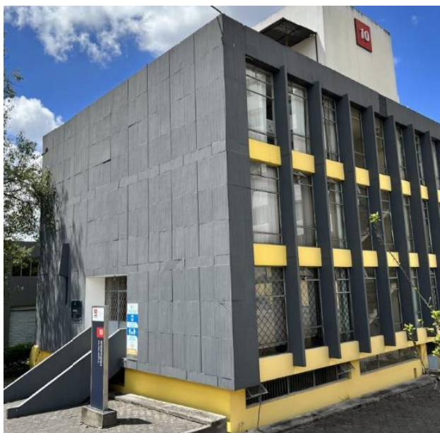
Figura 20. Edificio 10 de Hidráulica actualmente
