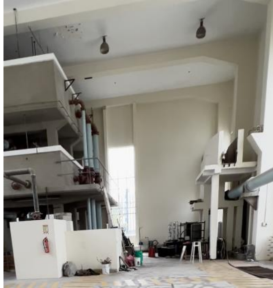
Figura 23. Vigas acarteladas del Edificio de Hidráulica
