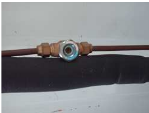
FIGURA 1.20: Indicadores herméticos de líquido y humedad.
