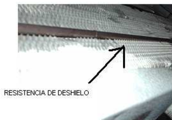
FIGURA 1.25: Resistencia de deshielo, parte posterior del evaporador.
