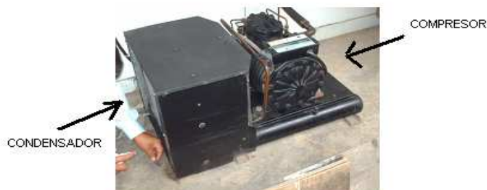
FIGURA 1.18: Unidad condensadora.
