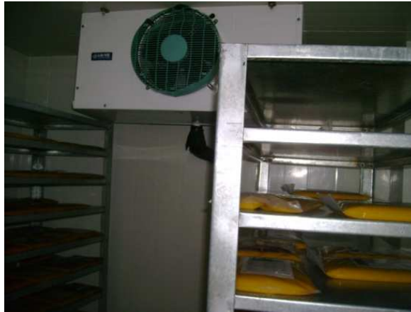
FIGURA 1.13: Túnel de enfriamiento.
