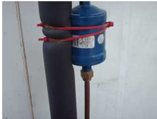
FIGURA 1.19: Filtro deshidratador.
