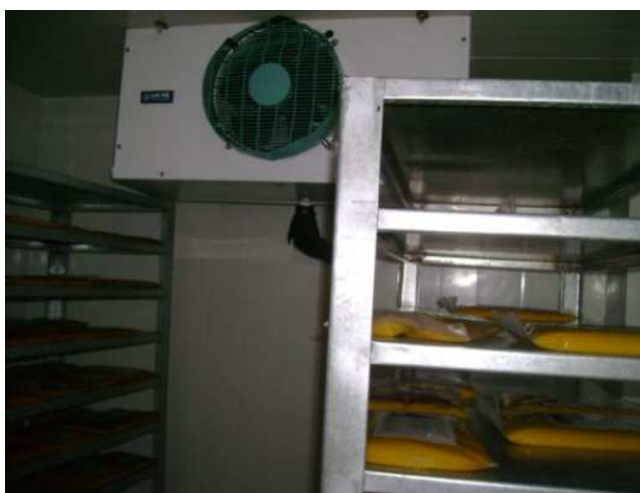
FIGURA 1.14: Cámara de congelación rápida por chorro de aire.
