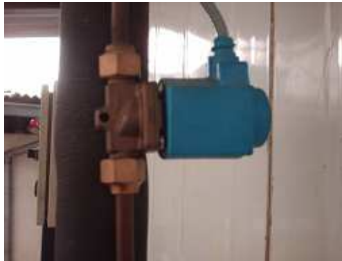
FIGURA1.21: Válvula de solenoide de dos vías, normalmente cerrada.
