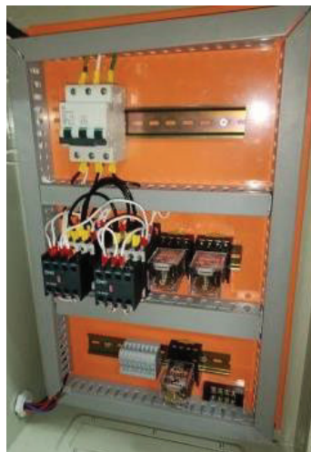
Figura 2.22 Panel interno finalizado.
