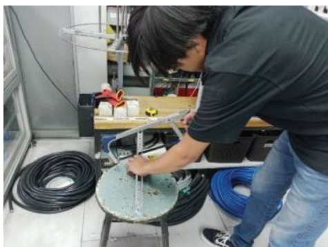
Figura 2.13 Corte canaleta para panel interno.
