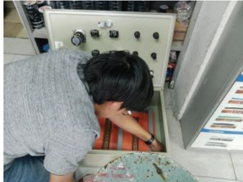
Figura 2.21 Montado y asegurado de panel interno.
