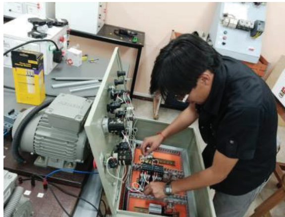
Figura 3.3 Armado de circuitos en tablero eléctrico.
