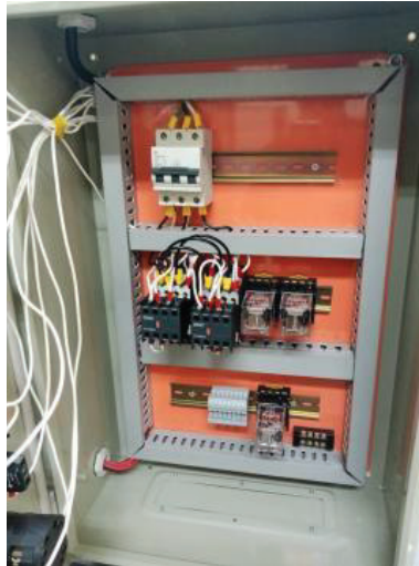
Figura 2.23 Cableado dentro de canaletas.
