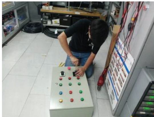
Figura 2.20 Montado y asegurado de elementos en panel frontal.
